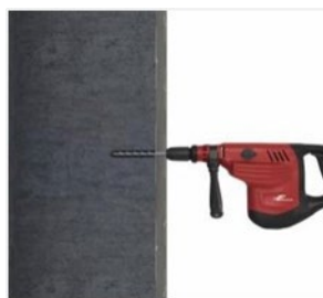
1. Сверление отверстий
