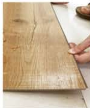
Система «Клик-Клак» - надежный монтаж с замковым соединением.
