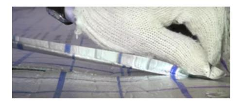
• Трубы раскладывают по контуру «змейкой» или «улиткой» шириной шага 150-300 мм. Синяя разметка на теплоизоляционном материале помогает правильнее разложить трубу по контуру.
