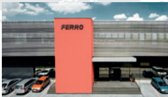
Главный офис FERRO в г. Скавина
