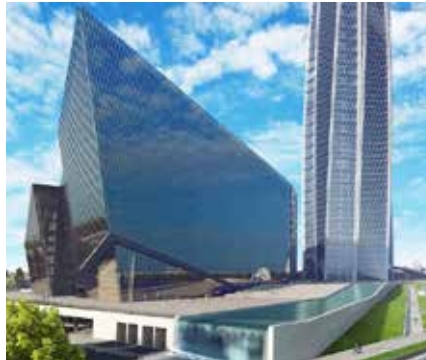
МФЗ ЛАХТА-ЦЕНТРА, САНКТ-ПЕТЕРБУРГ
