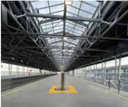
ПЛАТФОРМА ЖД ЛИНИИ К АЭРОПОРТУ ШЕРЕМЕТЬЕВО, МОСКОВСКАЯ ОБЛАСТЬ
