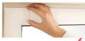
Обезжирьте поверхность оконной рамы в местах приклеивания. Приклейте монтажные площадки на раму.
