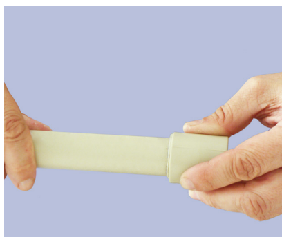
обработка граней соскабливание
